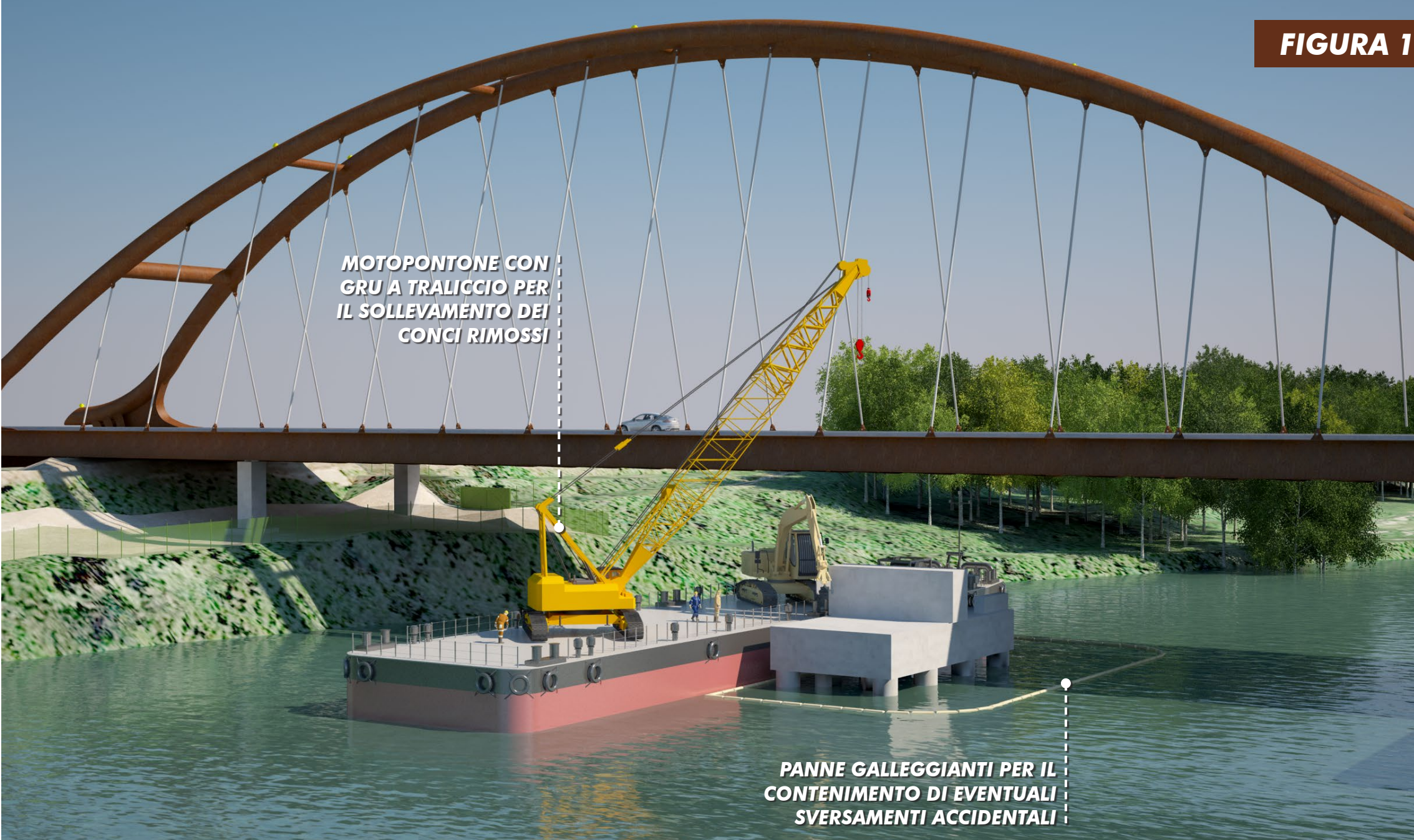
Fase 6: Demolizione fusti, fondazioni e pali - pile 2, 3 e 4
