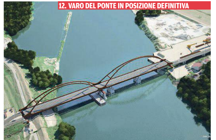
12. VARO DEL PONTE IN POSIZIONE DEFINITIVA
