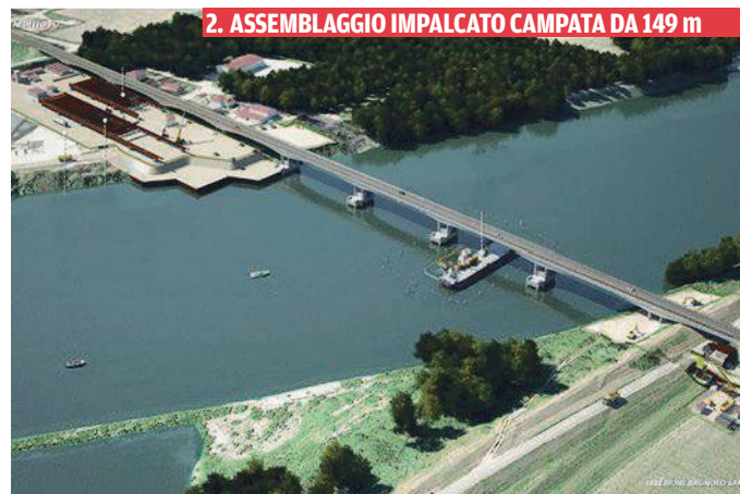
2. ASSEMBLAGGIO IMPALCATO CAMPATA DA 149 m
