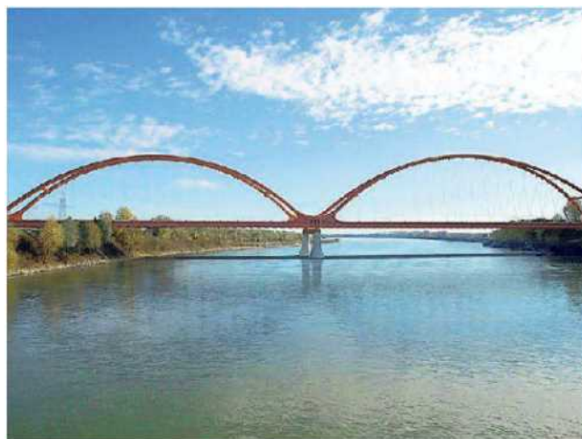
Così sarà il nuovo ponte sul Po fra San Benedetto e Bagnolo San Vito
