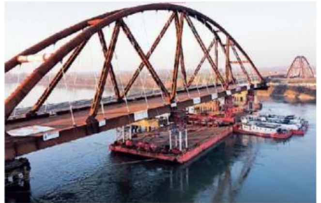
Da giovedì si sposta sul fiume anche il secondo arco del nuovo ponte
