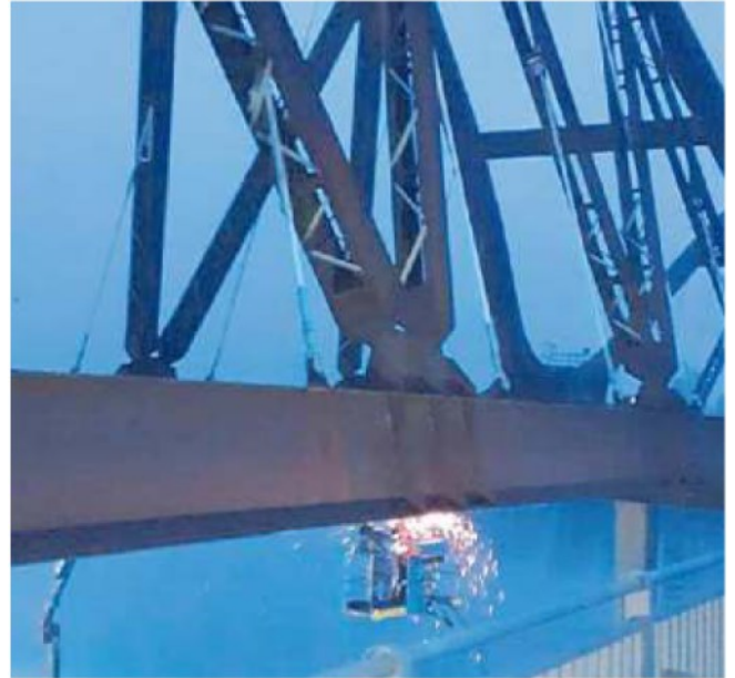
I saldatori al lavoro sotto le arcate
